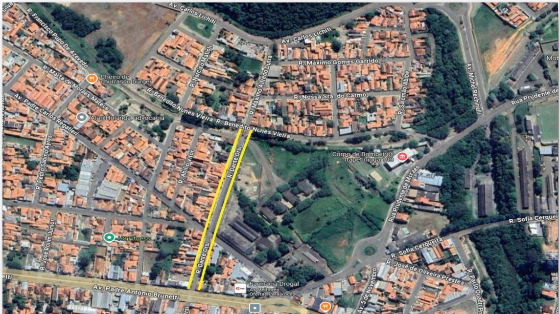
A.7.TRECHO DA AVENIDA JOSE DE ALMEIDA CARVALHO, COM CHUVAS TORRENCIAIS DE 41 MM, PROVOCAM FORTES ENXURRADAS E ALAGAMENTO
